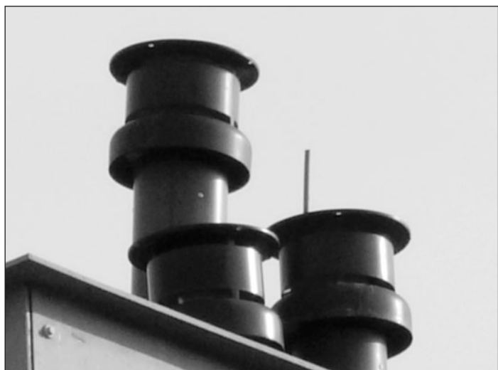
Obr. 1 Pohled na provedení vyústění – v pozadí vyšší vyústění nasává spaliny od dvou před ním vyústěních odvodů.
