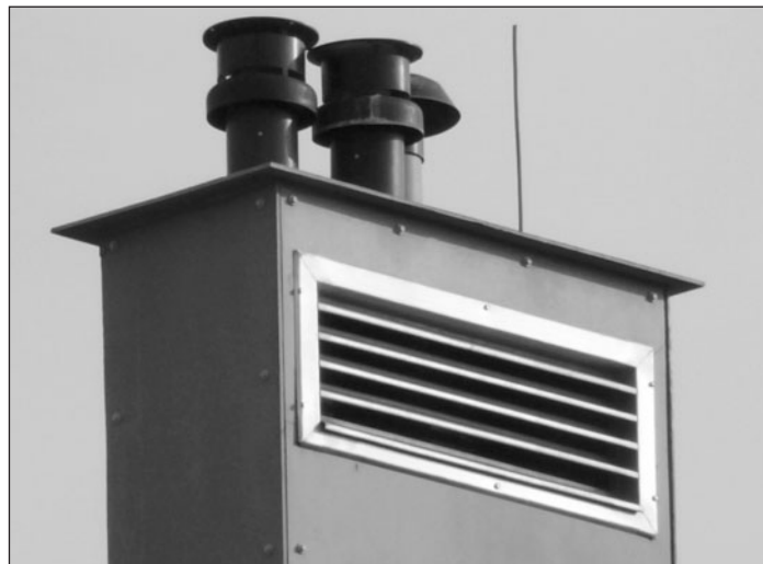
Obr. 3 Celkový pohled na konstrukci šachty s vyústěním odvodů spalín.
