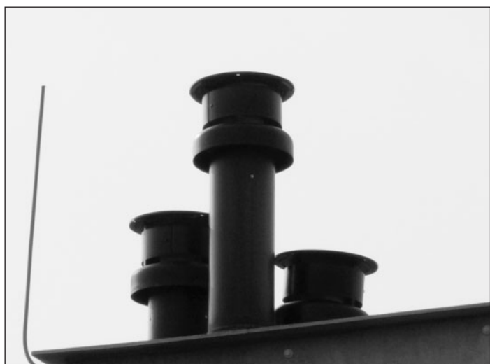
Obr. 2 Pohled na provedené vyústění – střední vyšší vyústění nasává spaliny od levého a pravého vyústění.
