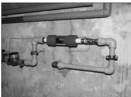
Obr. Montáž za vodoměr
