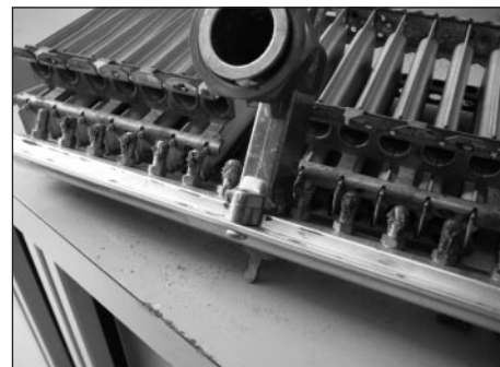
Obr. 9 Detailní pohled na vyjmuté znečištěné trysky z difuzoru (viz obr. 8).
