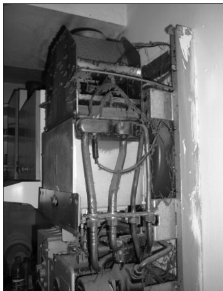
Obr. 3 Celkový pohled na stav kotle po jeho odkrytí.
