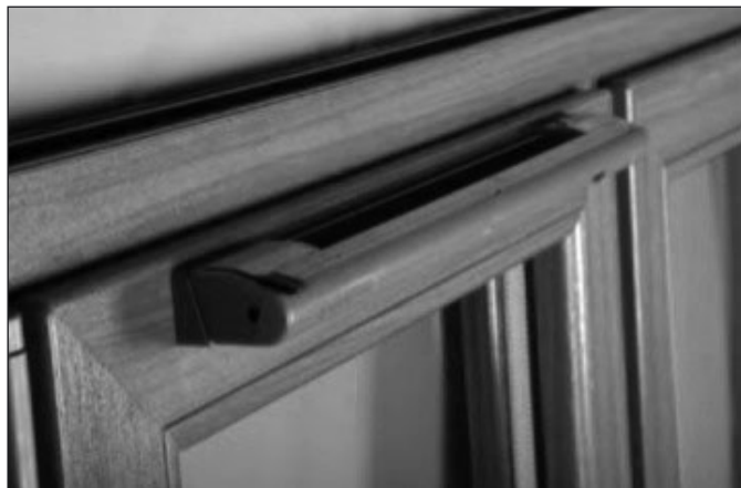
Obr. 5 – Příklad instalace okenní štěrbiny EMF 22 a venkovního krytu
