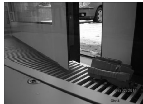
Obr. 4 – Detail pootevřených skleněných dveří s pohledem na odmontovanou spodní hranou s těsněním.
