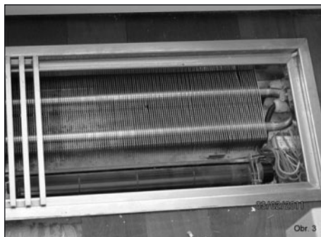
Obr. 3 – Uložení lamelového konvektoru s ventilátorem v podlaze.
