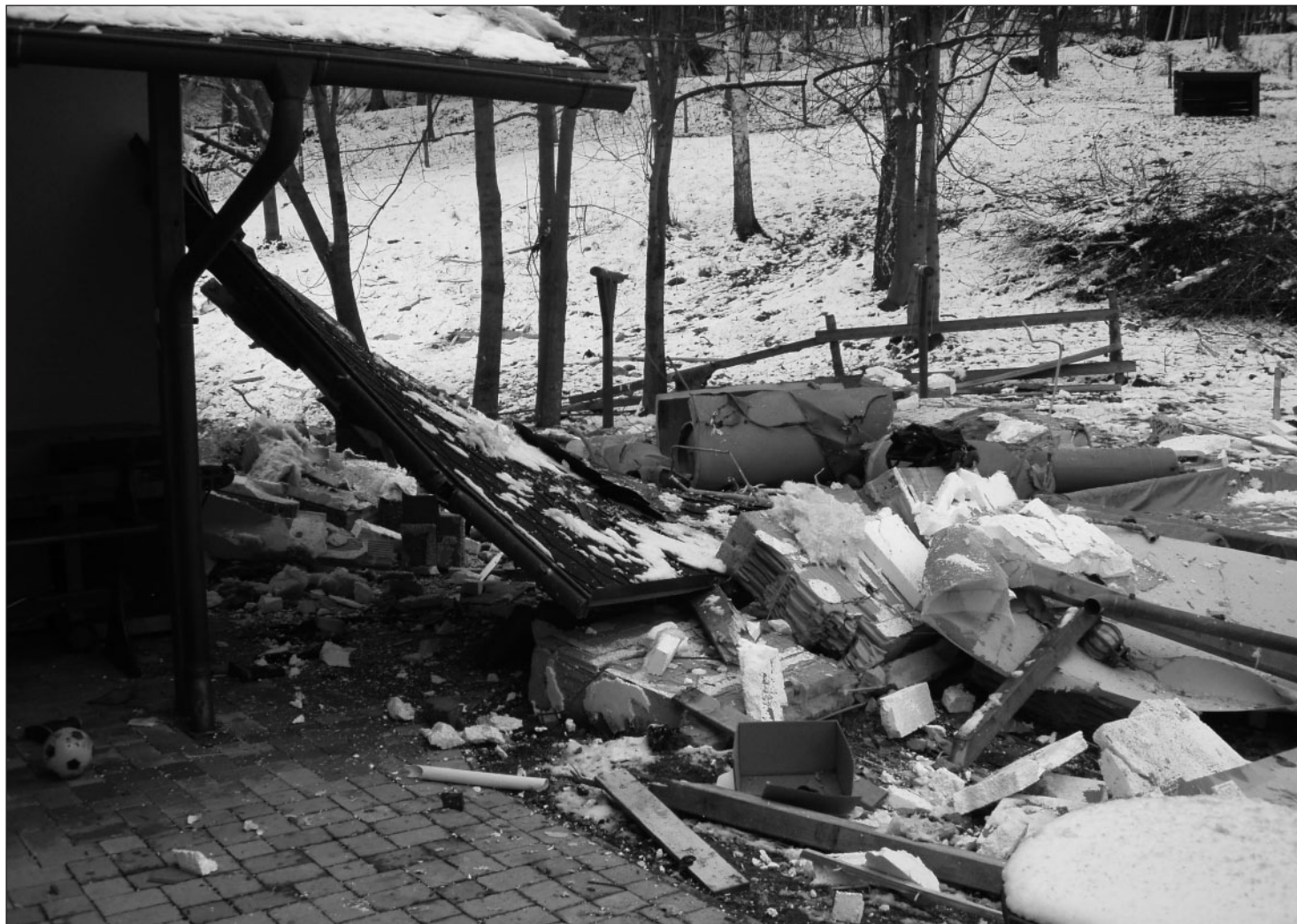
Pohled po částečném úklidu přístřešku.
