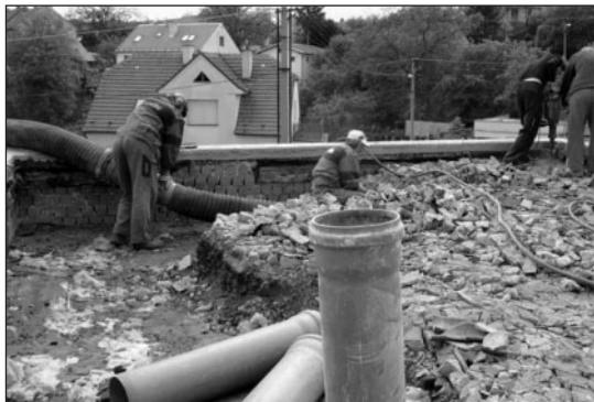
Technologie MTS umožňuje bezprašné odsátí sutě z kteréhokoliv patra budovy, od sklepa až po střechu.
