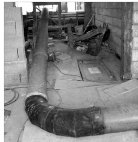
Nejdelší účinná vzdálenost odsávání materiálu je 80 m.
