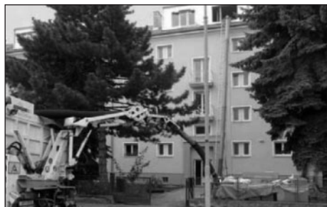
Stroj MTS DINO 3, který používá společnost HUTIRA - BRNO, s. r. o., při odsávání sutí z podkrovních místností.
