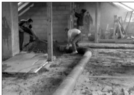
Materiál k ústí sacího potrubí přihrnoují pouze dva až tři dělníci.
