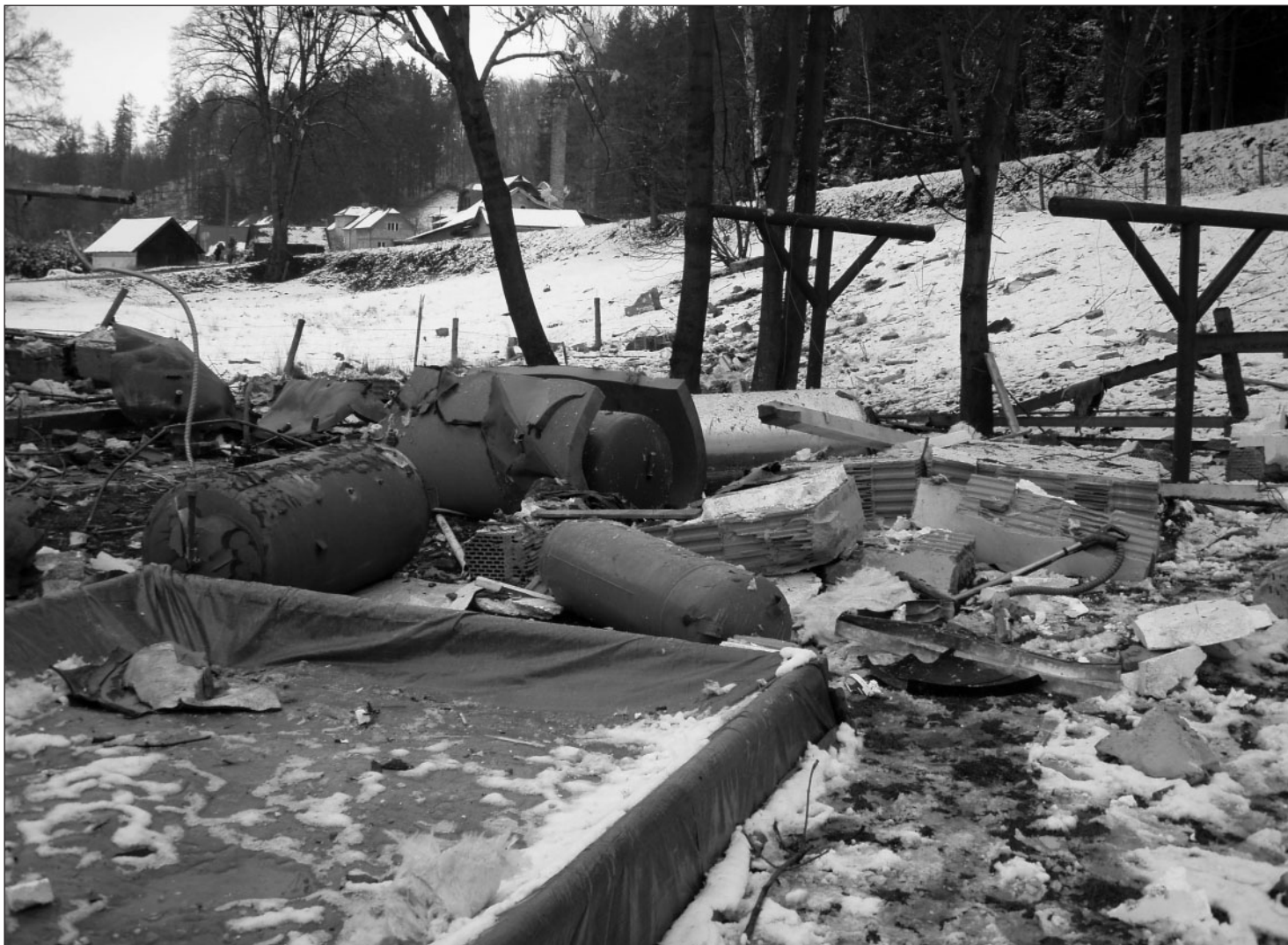
Pohled po odstranění stavebních prvků.
