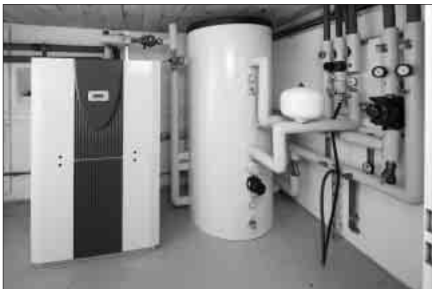
Obr. 5 Země-voda pro vytápění a chlazení hotelu.
