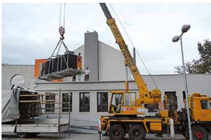
Kaskáda několika jednotek Robur, tzn. link, je z výroby připravený celek, hydraulicky a datově propojený, což umožňuje jeho snadnou integraci do stávajícího topného systému objektu. Snadná manipulace s takovýmto uskupením zjednodušuje a urychluje samotnou instalaci. Při umístění na střeše, pokud je k tomu vhodná, nebylo zapotřebí rozsáhlých stavebních úprav.
