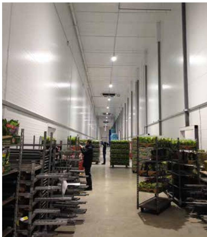
Oboustranně vyfukující chladiče (beidseitig ausblasende Güntner Kühler) Güntner DUAL Vario DGN s ventilátory s pomalými otáčkami účinně zabraňují, i mimo skladovací prostory, na chodbách a ve výrobních prostorách, vzniku nebezpečí vysušování zboží (die Gefahr der Produktaustrocknung) tím, že se starají o bezprůvanový způsob distribuce vzduchu (zugluftfreie Luftverteilung).
