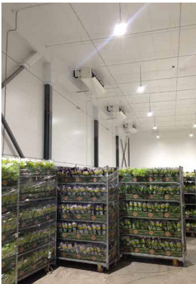
Oboustranně vyfukující chladiče (beidseitig ausblasende Güntner Kühler) Güntner DUAL Vario DGN s ventilátory s pomalými otáčkami účinně zabraňují, i mimo skladovací prostory, na chodbách a ve výrobních prostorách, vzniku nebezpečí vysušování zboží (die Gefahr der Produktaustrocknung) tím, že se starají o bezprůvanový způsob distribuce vzduchu (zugluftfreie Luftverteilung).
