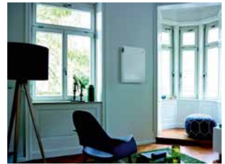
Decentrální větrací jednotka Zehnder ComfoAir 70
