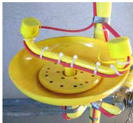
Podobný „zásah“ u oční sprchy. Zde je kabel překážkou při samotném spuštění... Navíc raménko u oční je z plastu!
