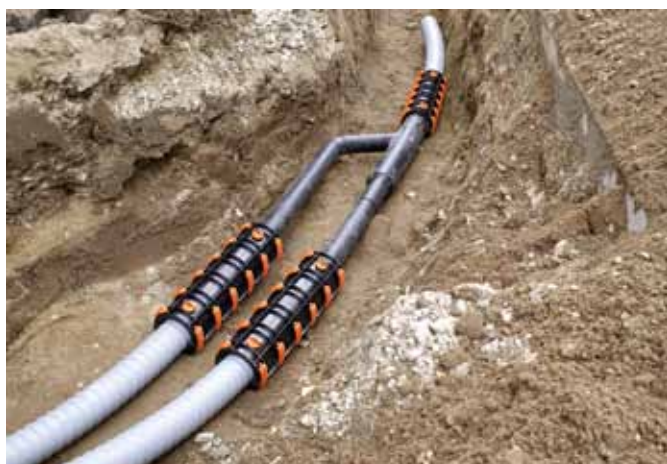
Přechod z potrubí UNA na DUO
