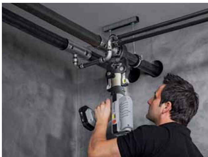
Nový systém „Megapress“ společnosti Viega je hospodárný a bezpečný: bleskurychlá lisovací technika pro silnostěnné ocelové trubky umožňuje zkrátit montážní čas o 60 procent oproti běžnému svařování (Foto: Viega)
