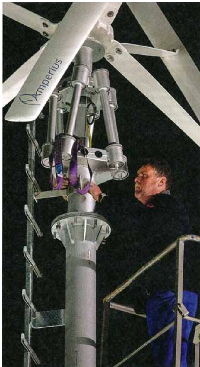
Obr. 5 Po četné dny a noci připravovali technici na nádraží Berlin Südkreuz konstrukci větrné elektrárny
