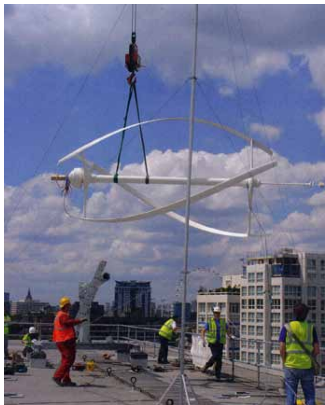
Obr. 2 Malá elektrárna na háku jeřábu. Zanedlouho bude dodávat elektřinu. Jedná se o výhodnou investici?
