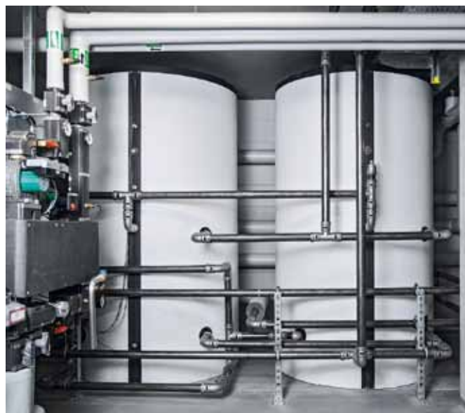
Spojky „Megapress“ jsou díky svému zinko-niklovému povlaku z výroby obzvláště odolné proti korozi. Lze je používat v topných a chladicích zařízeních bez dodatečného antikorozičního nátěru (Foto: Viega)
