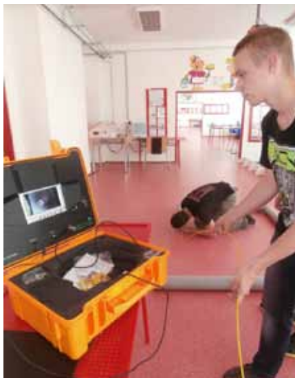
Obr. 2 Vyhledávání věcí v kanalizačním potrubí inspekční kamerou
