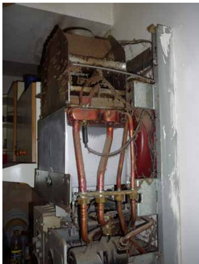
Obr. 3 Celkový pohled na stav kotle po jeho odkrytí
