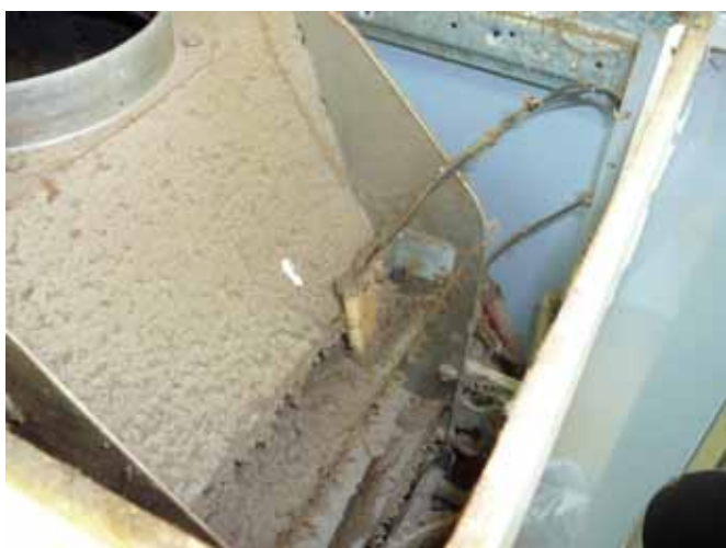
Obr. 6 Detailní pohled na instalované čidlo pojistky zpětného toku spalín se známkami značného znečištění včetně silných úsad nečistot v celém okolí
