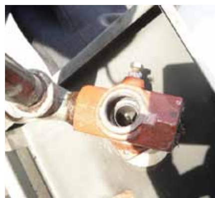
Obr. 7 Pohled do spodní části kohoutu s termoelektrickou pojistkou, kde došlo k demontáži
