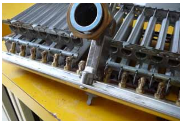
Obr. 9 Detailní pohled na vyjmuté znečištěné trysky z difuzoru (viz obr. 8)
