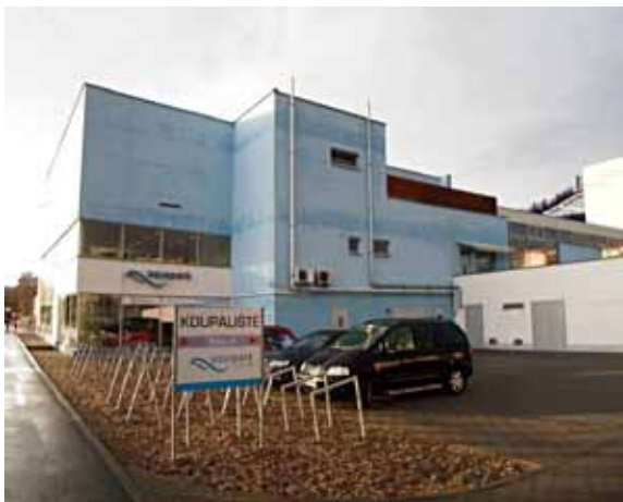
Obr. 1 Ukázka projevu šíření vodní páry stavební konstrukcí na fasádě objektu
