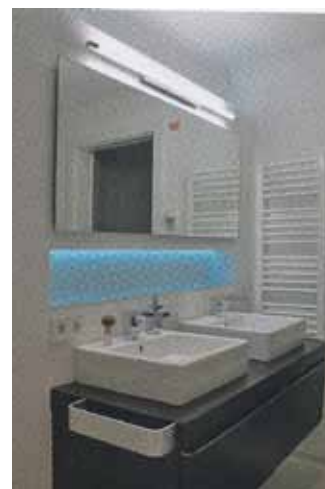
Obr. 9 Alternativa barevného osvětlení z obr. 13 v nice pod zrcadlem pomocí příslušného RGB-pásu (foto Licht-Kraus)
