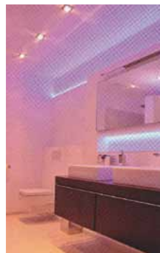
Obr. 8 Barevné osvětlení koupelny pomocí RGB-LED pásu, umístěným v nice pod zrcadlem a v odsazeném fabionu za zrcadlem (foto Licht-Kraus)
