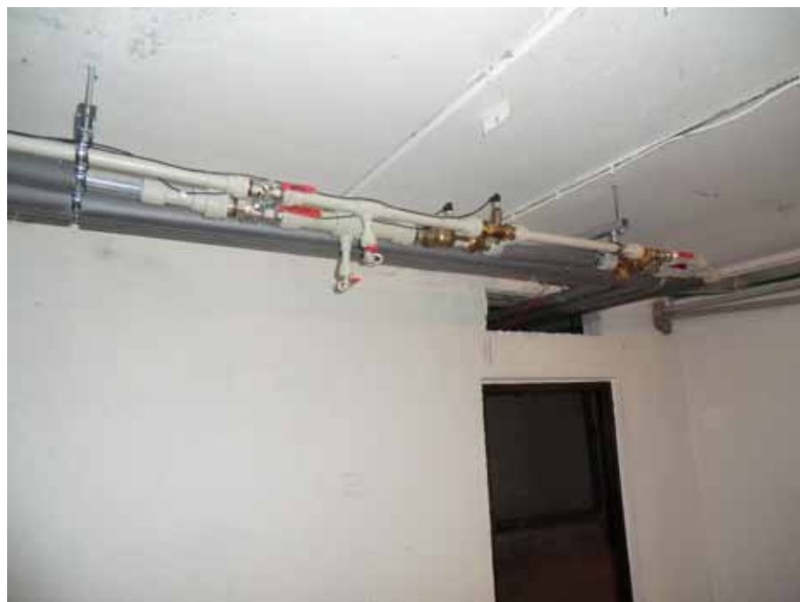
Obr. 3 Osazení průtokoměrů ve studentkých kolejičkách
