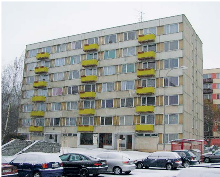
686 a 687 před opravou...
