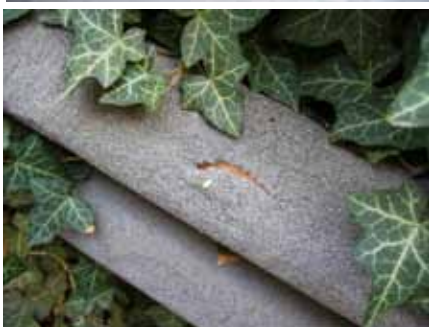
Obr. 5 Nevhodná tepelná izolace [6]
