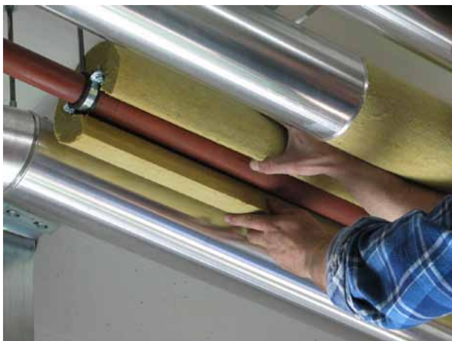
Obr. 1 Izolace teplovodního potrubí s kruzí z minerální vlny Knauf Insulation
