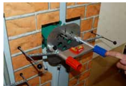
Instalace podomítkového tělesa za pomoci instalační platně č.1 (ilustrace na panelu)
