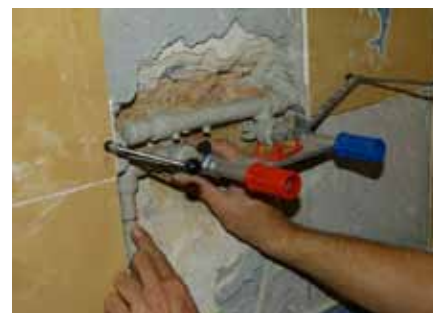
Instalace podomítkových kolen za pomoci vodováhy
