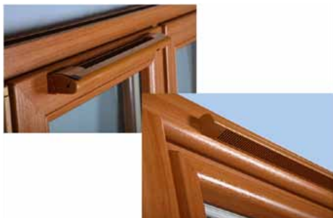
Obr. 14 Ukázky instalací větracích štěrbin
