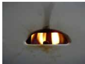
Obr. 4 Typický plamen spotřebiče s vysokým obsahem CO – zářivě žlutý plamen
