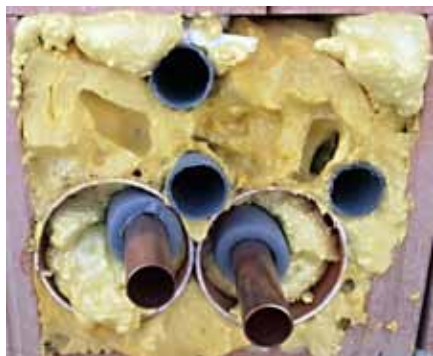
Obr. 1 Zapěněný vstup
