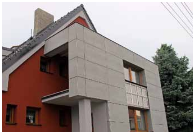
Odvětraná fasáda rodinného domu Obříství
