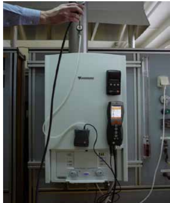
Obr. 28 Schéma uspořádaní zařízení pro současné měření tahu komína a spalin Tabulka 1 Výsledky měření – vliv digestoře
