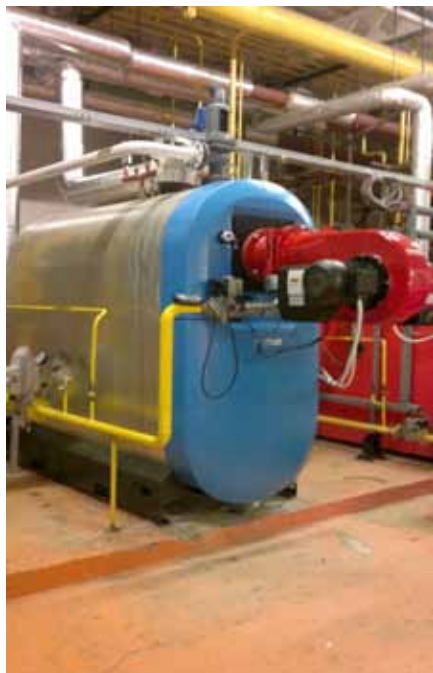
Obr. 2 Nerezové stacionární kondenzační kotle Buderus Logano plus SB745
