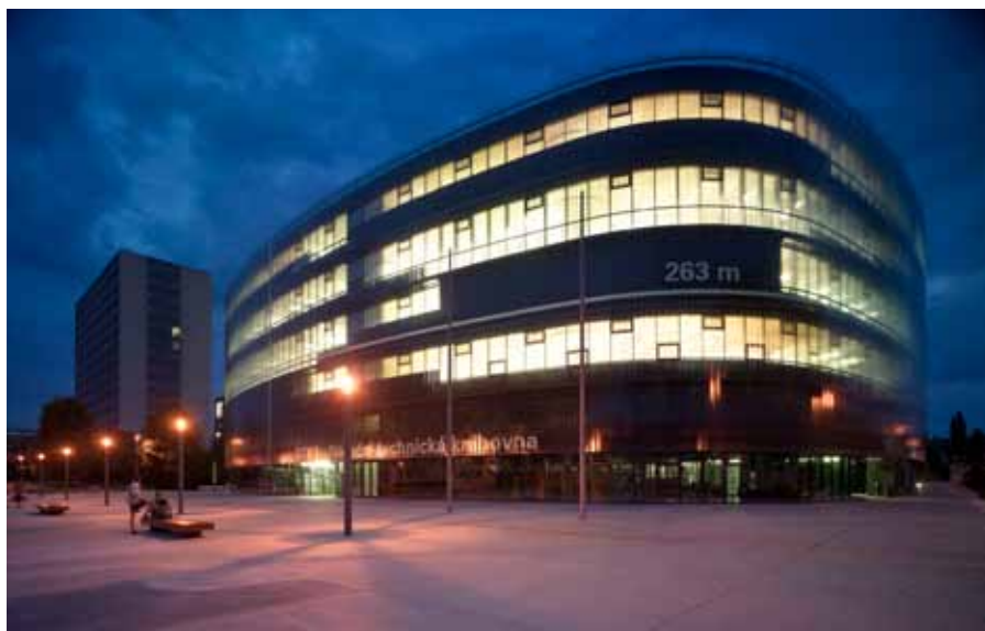
Budova Národní technické knihovny patří k prvním inteligentním budovám v Praze. Technologie společnosti Siemens umožňují centrálně ovládat vytápění, chlazení, osvětlení i vnější žaluzie a snižují tak provozní náklady
