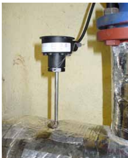
Obr. 3 Použití platinového teploměru zcela nevhodné délky
