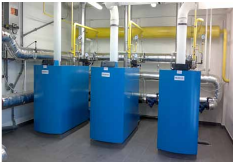
Obr. 3 Kaskáda úsporných stacionárních kondenzačních kotlů Logano plus GB402
