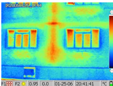
Obr. 8 Termosnímek bytového domu před rekonstrukcí
