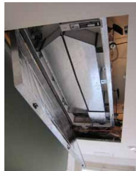
Obr. 3 Revizní otvor ve stropě
