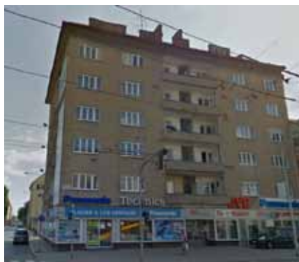
Obr. 2 Bytový dům před zateplením fasády
