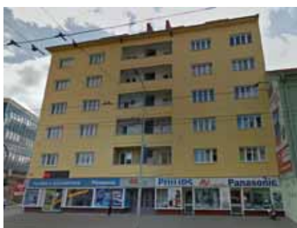
Obr. 3 Ukázka bytového domu po zateplení fasády
