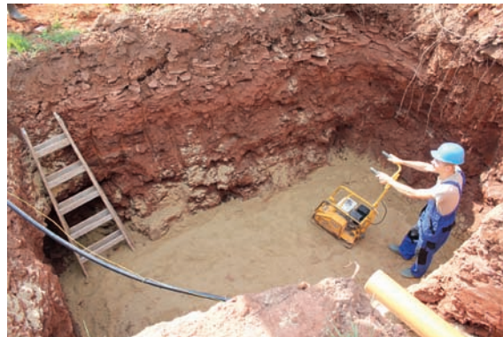
Obr. 5. Příprava výkopu na uložení nádrže
