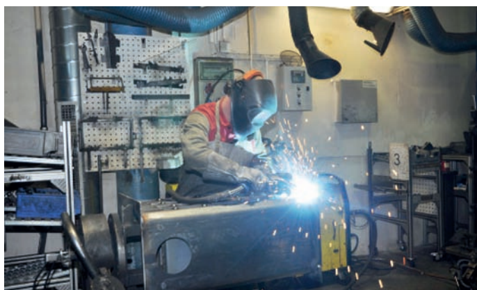
Obr. 1. Sváření ocelového kotle Dakon DOR F
