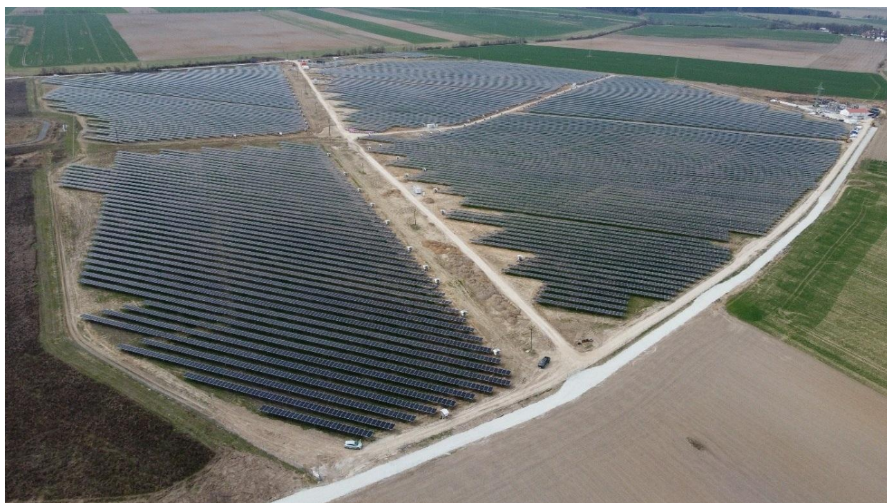
Letecký pohled na FVE Stella v Dyníně
