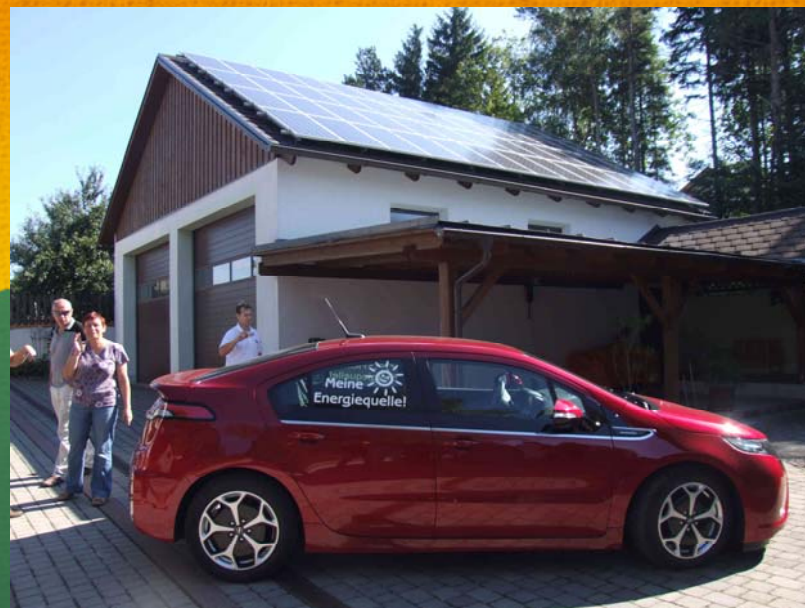
Ottenschlag: FVE na střeše + elektroauto
