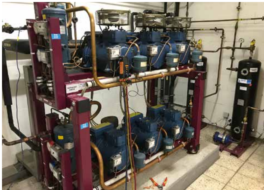
Sdružená kompresorová jednotka TEKO ve strojovně supermarketu K + K (Foto: Daikin)
