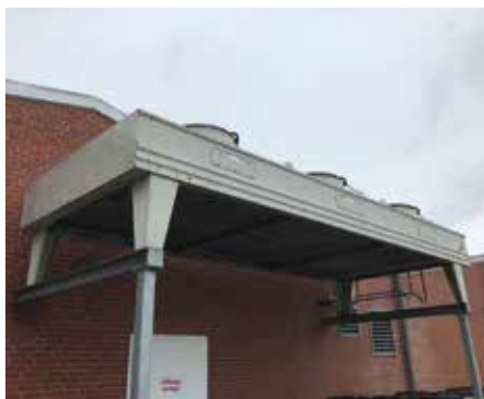
Kondenzátor umístěný mimo objekt (im Außenbereich) (Foto: Daikin)
