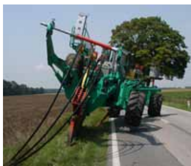
Bezvýkopová pokládka kabelů (str. 32)
