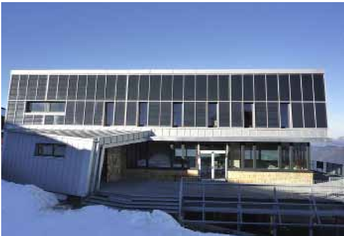
Ludwig Walter Haus/Kärnten: Gipfelhaus na Dobratsch v n.v. 2143 m. Arch. DI Weratschnig, Transform Architekten ZT-GmbH
