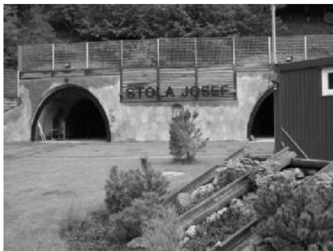
Obr. 9.1 Pohled na vchod do štol
