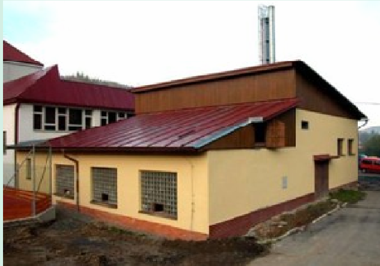
Kotelna 1,5 MW (0,9 MW a 0,6 MW – palivo piliny)
