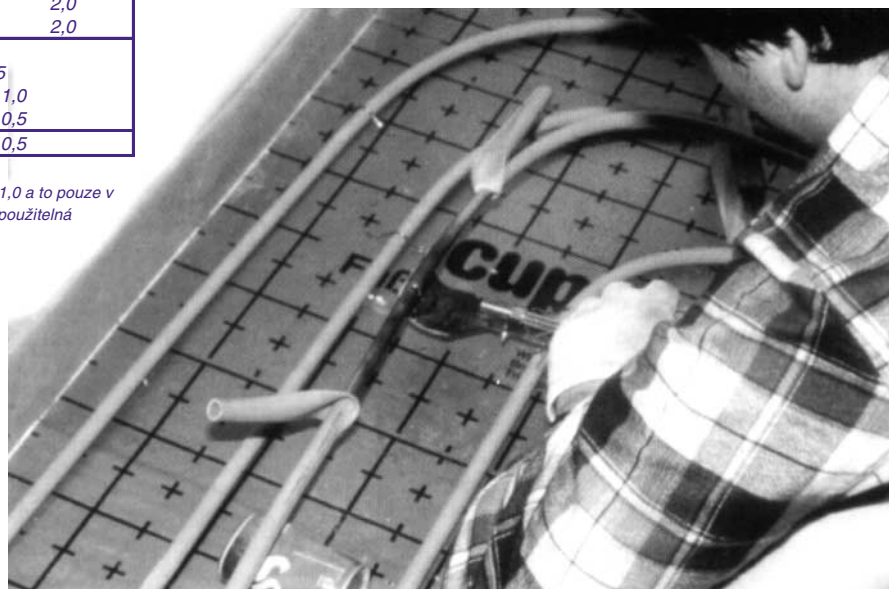
Obr. 13: Kladení podlahového vytápění s měděnými trubkami (DKI A 3525)
