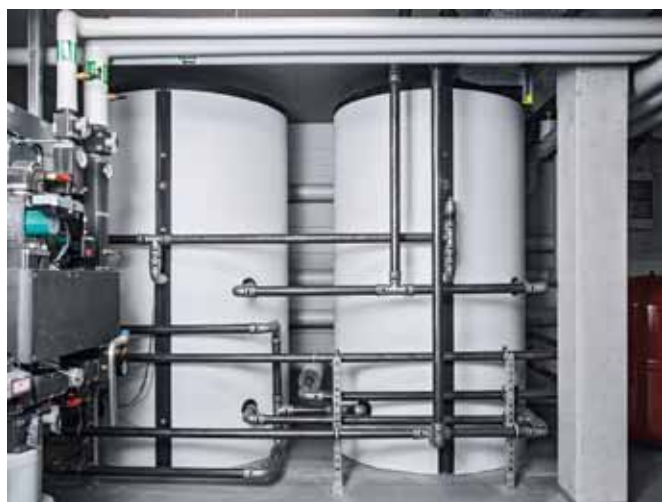
Spojky „Megapress“ jsou díky svému zinko-niklovému povlaku z výroby obzvláště odolné proti korozi. Lze je používat v topných a chladicích zařízeních bez dodatečného antikorozičního nátěru
