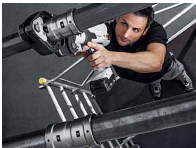
Bez námahy ve srovnání se svařováním: Systémem „Megapress“ společnosti Viega lze bez námahy slisovat ocelové trubky pod stropem
