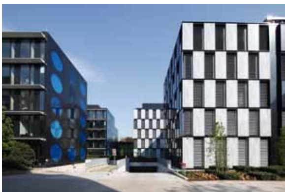
Fasády objektů B.O.C. i T.O.C. jsou charakteristické geometrickými tvary. Černobílý šachovnicový vzor objektu B.O.C. kontrastuje s metalickými černomodrými kruhovými obrazy sousedícího objektu T.O.C.
