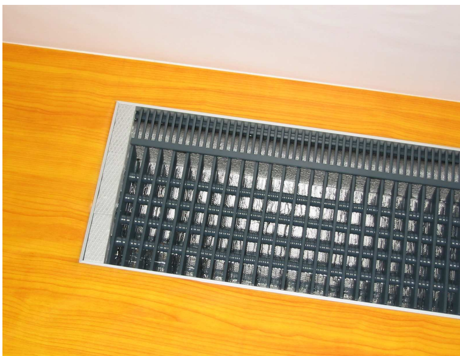
Obr. 3 Pohled na detail levé strany instalovaného podlahového otopného tělesa BITHERM Floor 245/1000
