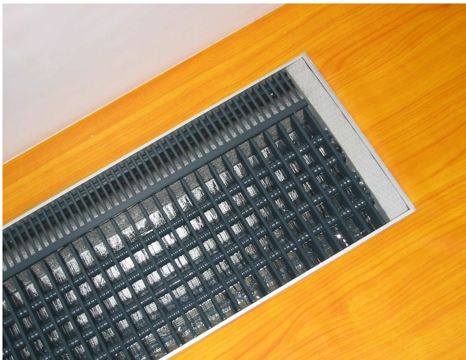
Obr. 2 Pohled na detail pravé strany instalovaného podlahového otopného tělesa BITHERM Floor 245/1000
