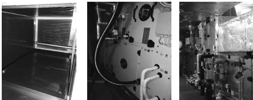
Obr. 3 - Ukázka zvlhčovací komory umístěné ve VZT jednotce a napojení distributoru na parní trubici lokálního vyvíječe páry (vlevo), ukázka distributoru páry, včetně regulace nástřiku, separace a odvodu kondenzátu při centrální výrobě a distribuci páry (vpravo)
