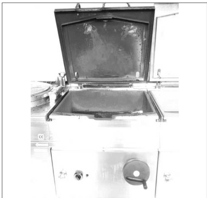
Obr. 1 - Celkový pohled na plynový spotřebič s otevřeným poklopem.
