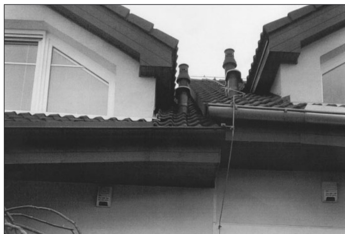
Obr. 3 Příklad vyústění potrubí odvodu spalin
