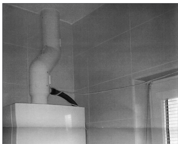
Obr. 2 Příklad instalace plynového kotle v koupelně
