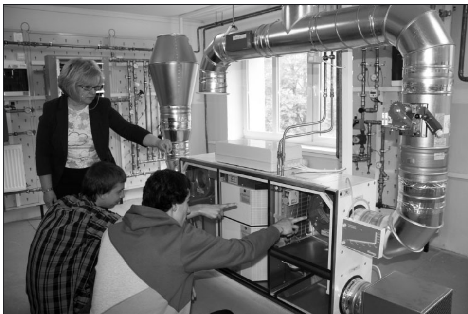
Klimatizační jednotka pro výuku oboru Technická zařízení budov
