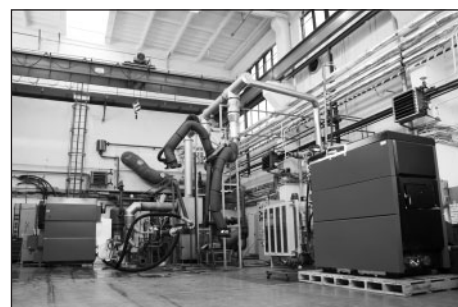
Zkušebna kotlů na tuhá, kapalná a plynná paliva.
