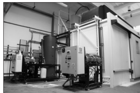
Zkušebna tepelných čerpadel.
