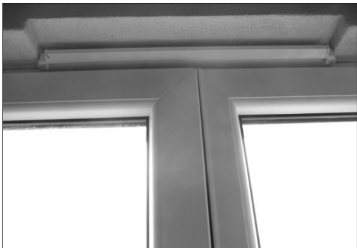
Obr. 5 - Pohled na větrací mřížku nad oknem.
