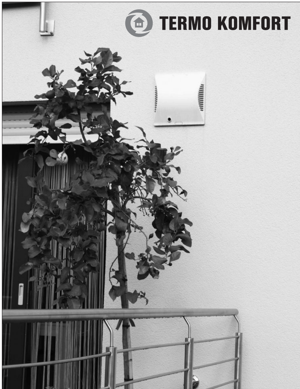
Lokální rekuperační jednotka Dimplex DL 50 – venkovní pohled.
