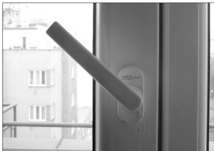
Obr. 6 - Pohled na stav uzavření okna.
