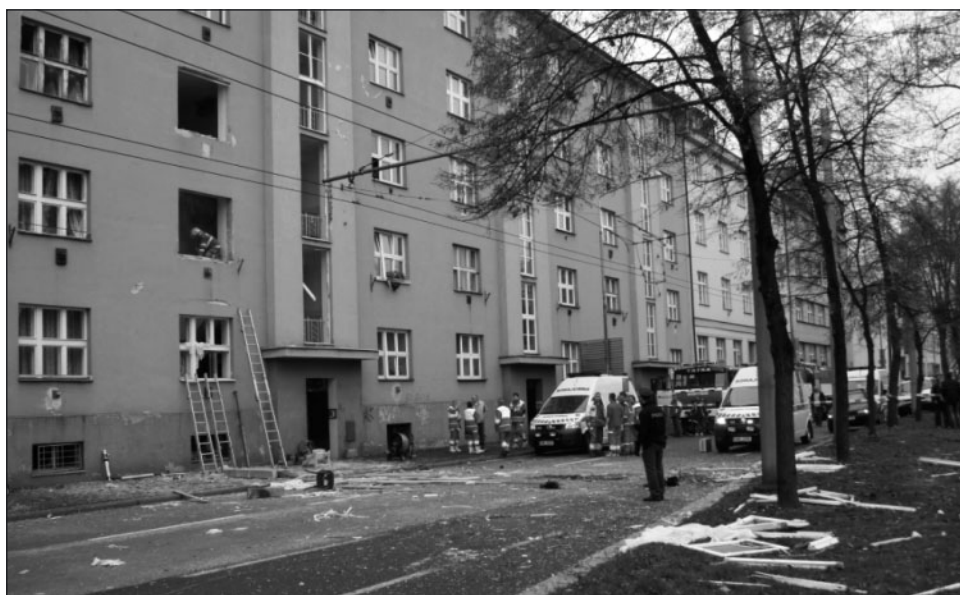
Obr. 8 Pohled na objekt, kde došlo k výbuchu.
