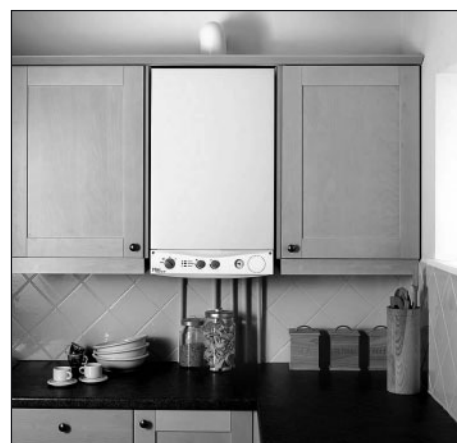
Obr. 2 Závěsný kombinovaný průtokový plynový kotel umístěn v kuchyni [3.]
